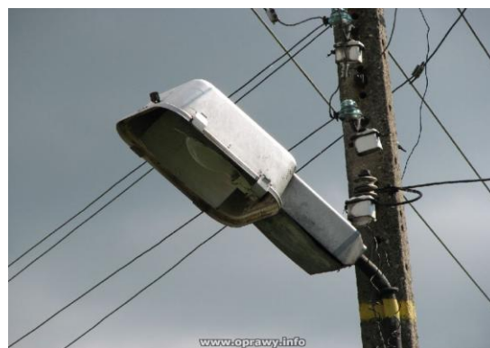
Oprawa OUR 250 bez klosza, pod linią. Odbłyśnik i źródło światła o niskiej sprawności. Bezużyteczna oświetleniowo.
